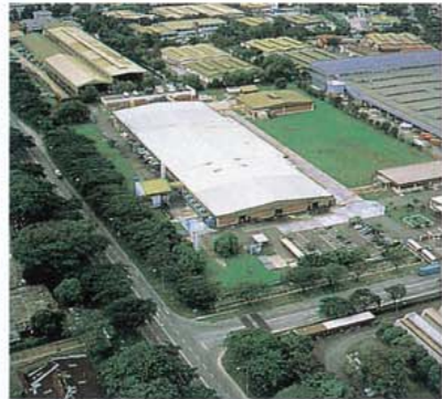
裕龙工厂(新加坡)
